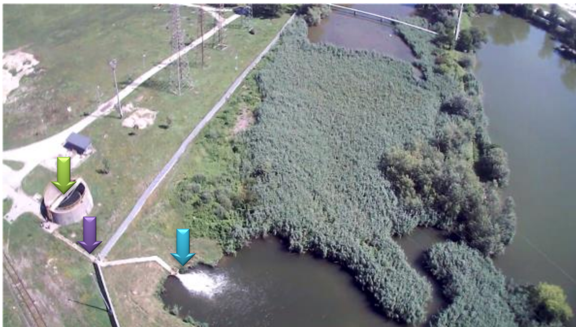
Slika 1-10 Ispust rashladne vode u jezero Savicu
