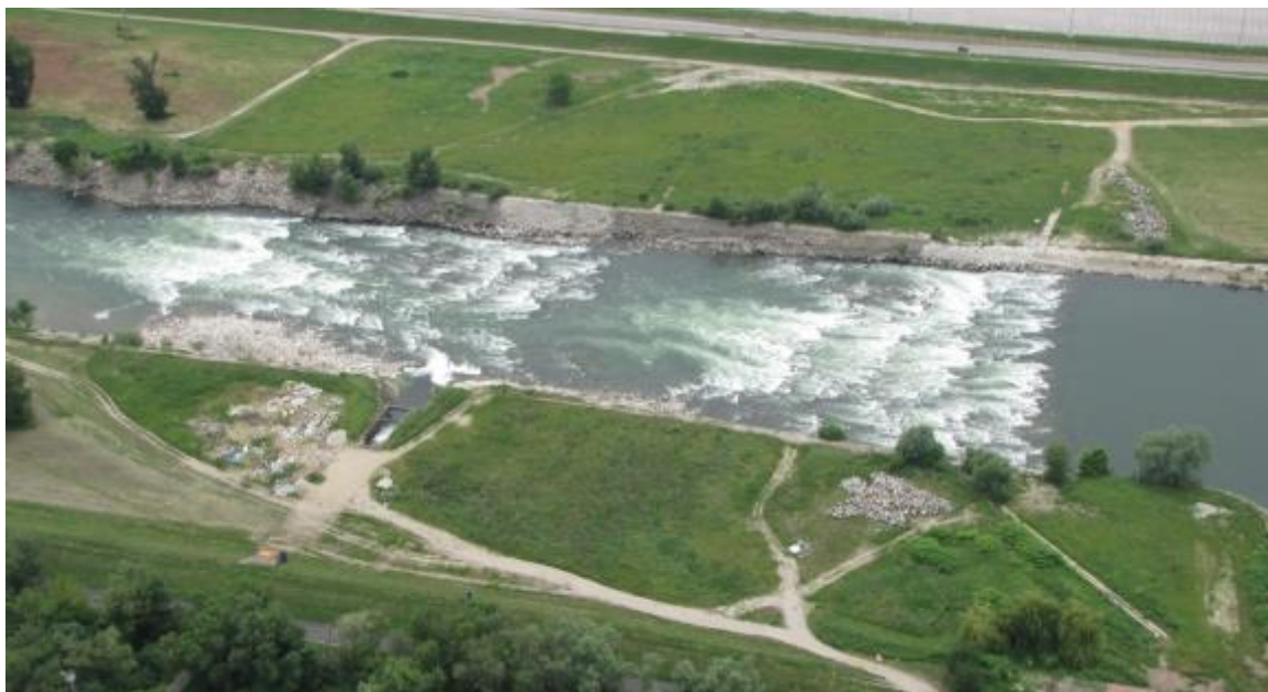
Slika 1-8 Prag na Savi za održavanja potrebnog vodostaja za vrijeme niskih protoka Save
