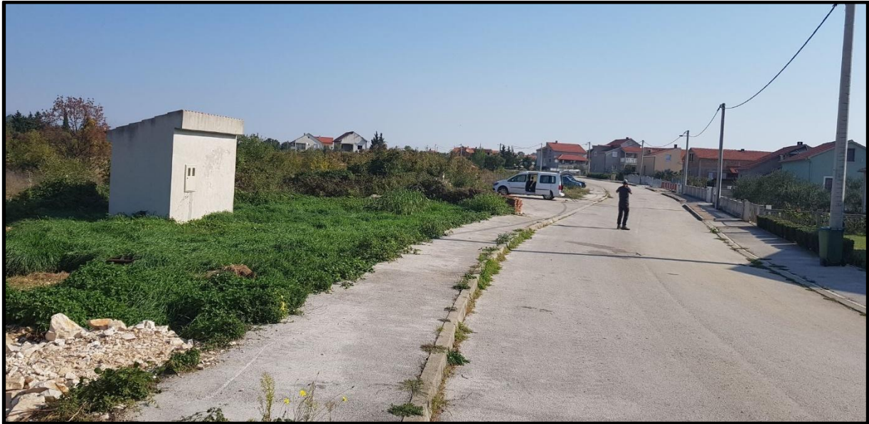
Slika 2.1-3. Postojeći UPOV uz prometnicu u naselju Ograde
