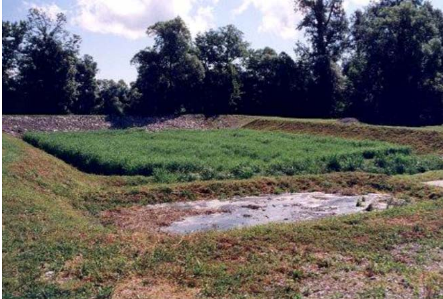
Slika 3 Postojeći biljni uređaj za pročišćavanje Žminj
