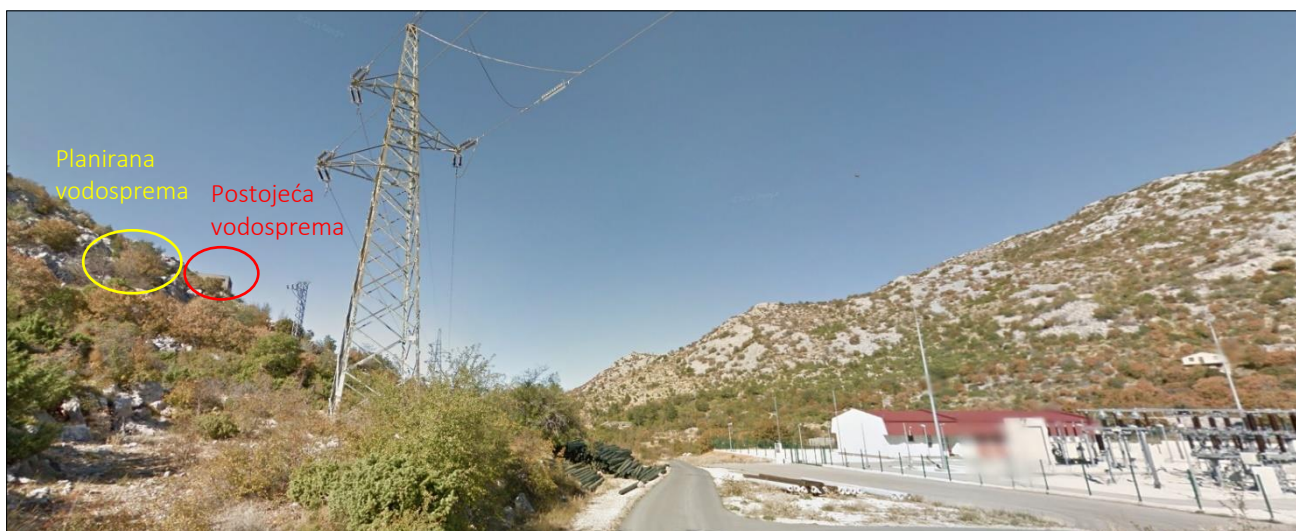
Slika 3.15-2 Položaj trafostanice TS 110/20 kV i dalekovoda DV 110kV u odnosu na postojeću i planiranu vodospremu (izvor: https://www.google.com/maps )
