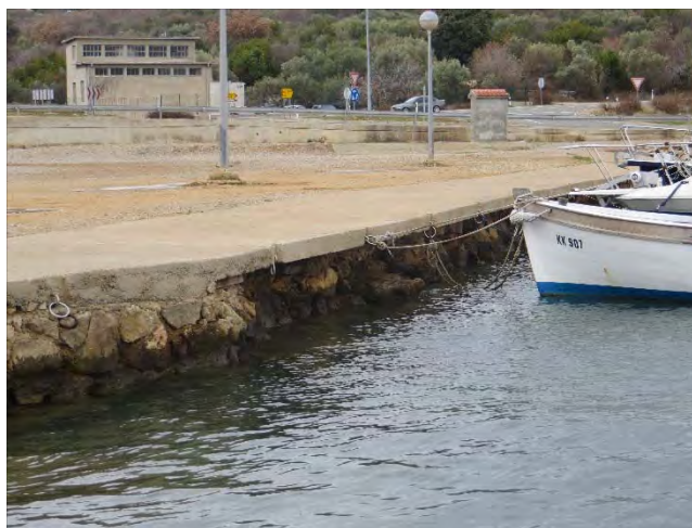
Fotografija 4: Armiranobetonska obala za privez plovila
