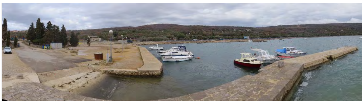
Fotografija 1: Panoramski prikaz postojećeg stanja luke Dunat (pogled s postojećeg gata prema sjeveroistoku)
