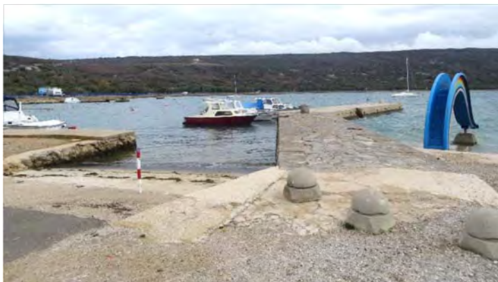
Fotografija 2: Postojeći masovni betonski gat i istezalište
