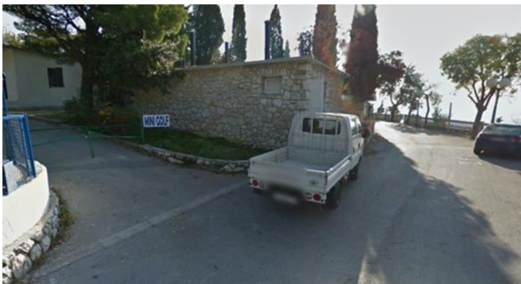
Slika 2.1.2-3. Pogled na crpnu stanicu CS SLAVEN
