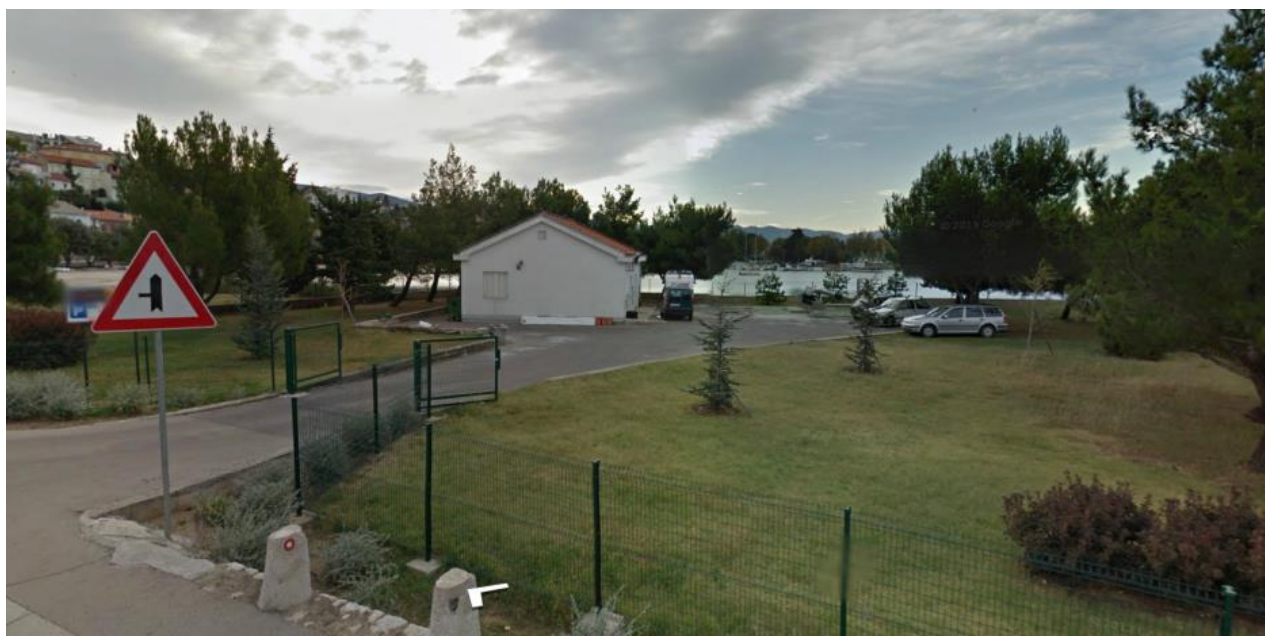
Slika 2.1.2-2. Pogled na građevinu mehaničkog predtretmana i crpnu stanicu MT/CS Ričina
