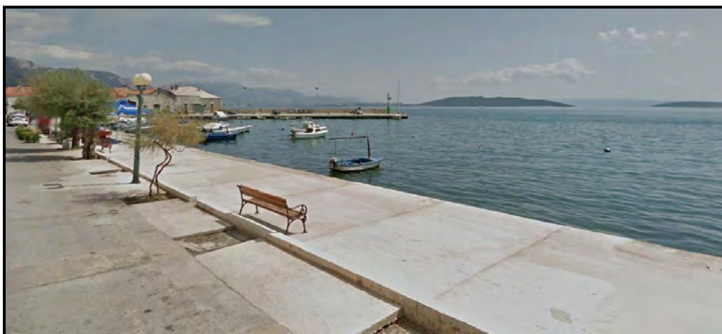
2.1-3. Postojeće stanje lokacije zahvata: dio uz Obalu Kralja Tomislava (1)
