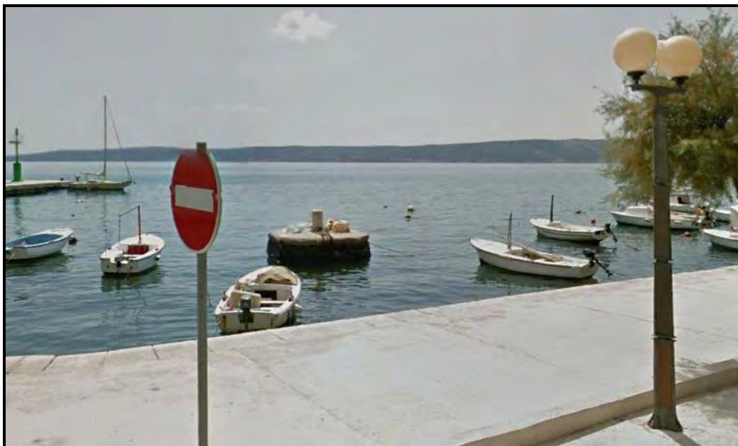
2.1-5. Postojeće stanje lokacije zahvata: stara kolona
