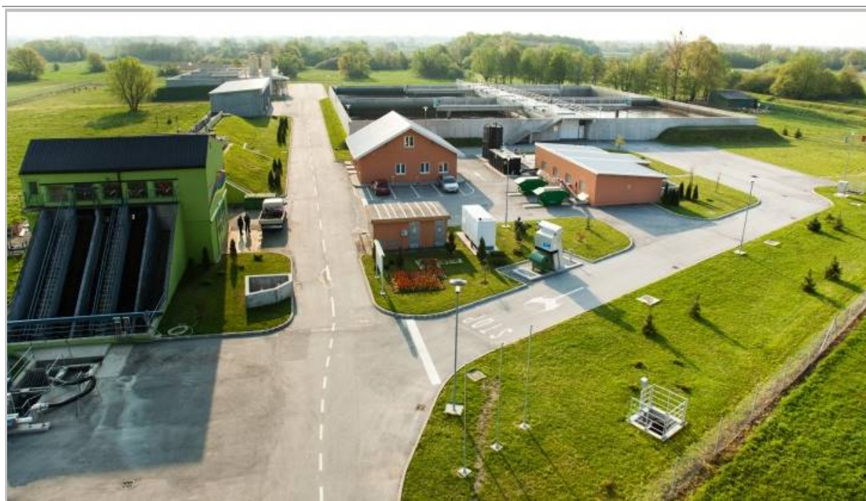
Slika 2-4. Postojeće postrojenje za pročišćavanje otpadnih voda (UPOV)
