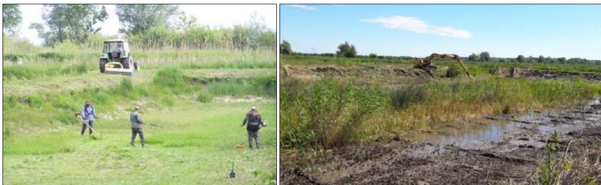
Košenje i održavanje nasipa te čišćenje proizvodnih tabli ribnjaka
