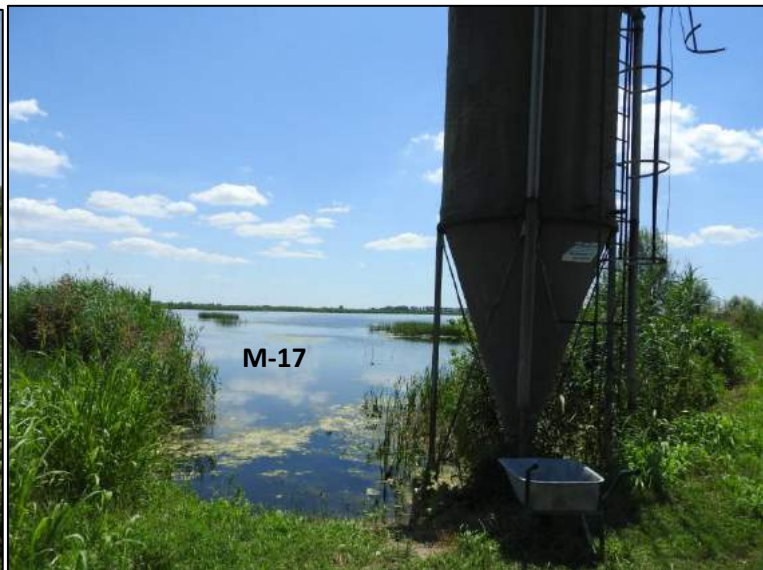
Silos pokraj table M-17 koja služi za hranidbu riba
