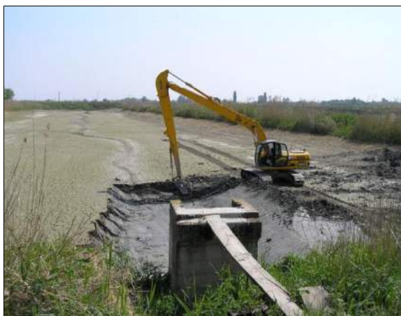
Strojno izmuljivanje izlovne jame i izlovnog kanala ribnjaka
