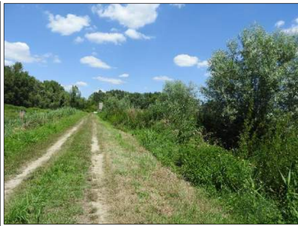
Postojeći nasip između tabli M-15 i M-17
