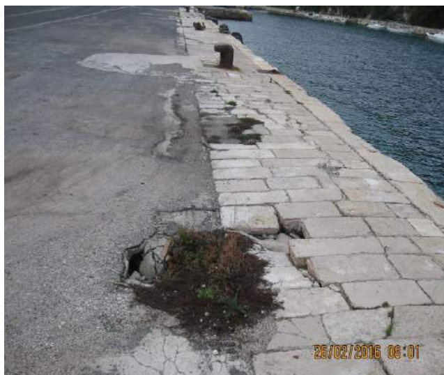
Slika 3.1.1-8. Pukotinski sustav i zalijeganje površine obalnog zida
