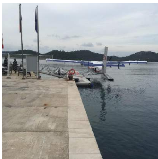
Slika 3.1.1-6. Izgled obalnog zida kod pomorskog graničnog prijelaza i hidroavionskog pristaništa
