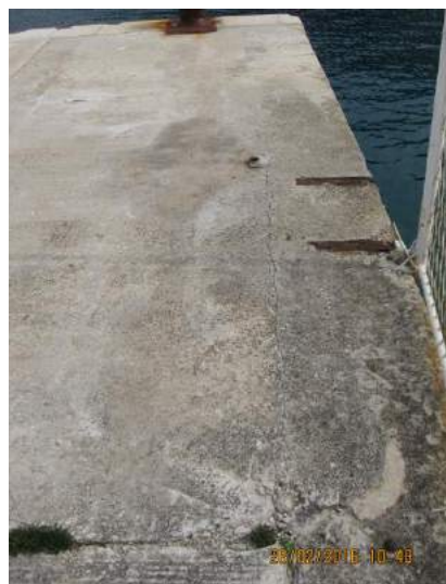
Slika 3.1.1-9. Oštećenja plažnog platoa i obalnog zida sjeverno od pristana te paralelna pukotina na pristanu hidroaviona
