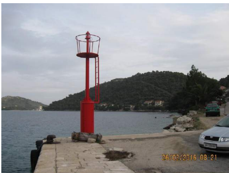
Slika 3.1.1-7. Pukotinski sustav kod lučkog svjetionika
