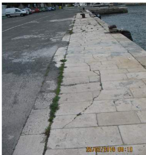
Slika 3.1.1-8. Pukotinski sustav i zalijeganje površine obalnog zida
