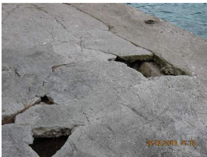
Slika 3.1.1-9. Oštećenja plažnog platoa i obalnog zida sjeverno od pristana te paralelna pukotina na pristanu hidroaviona
