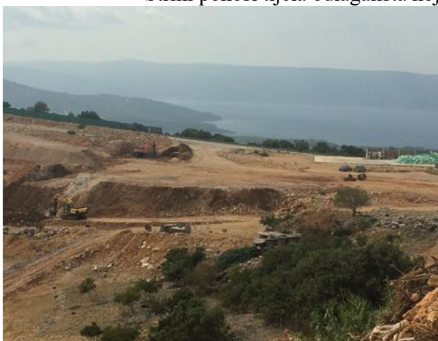
Izvođenje radova na uređenju ulazno-izlazne zone i izgradnji pretovarne stanice
