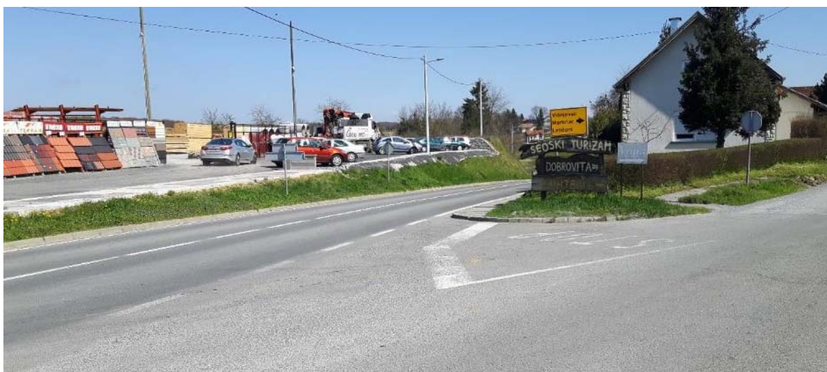
Slika 3.2.9.-6. Pogled prema lokaciji završetka trase planiranog zahvata (Đurđevačka cesta i Ulica Vijenac)
