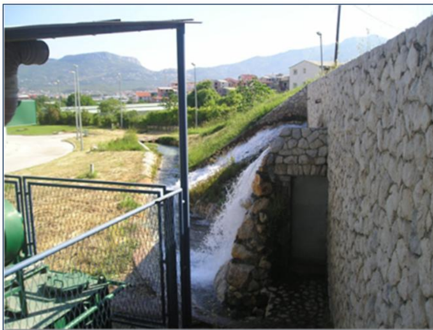
Fotografija A.2. Preljevanje vode kod CS Ravne Njive
