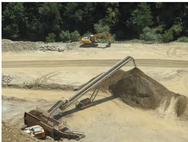
Slika 1.10. Utovar bagerom gusjeničarom u pokretno postrojenje za klasiranje
