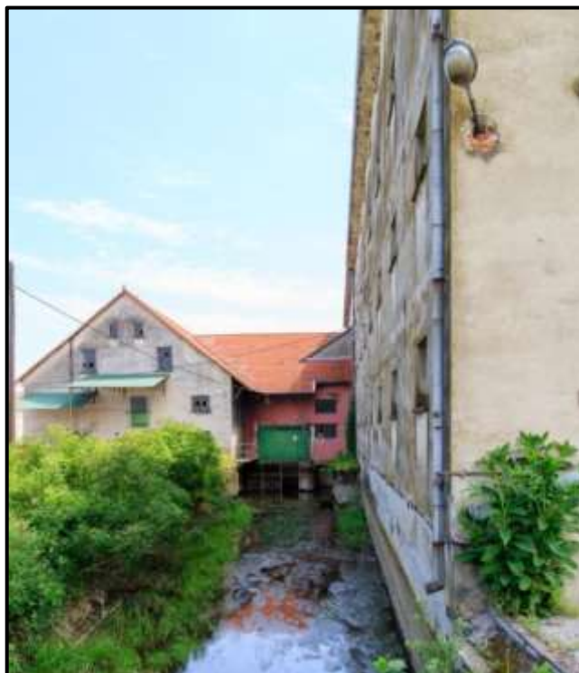
Slika 2-13 Postojeće stanje zgrade strojarnice i mlina
