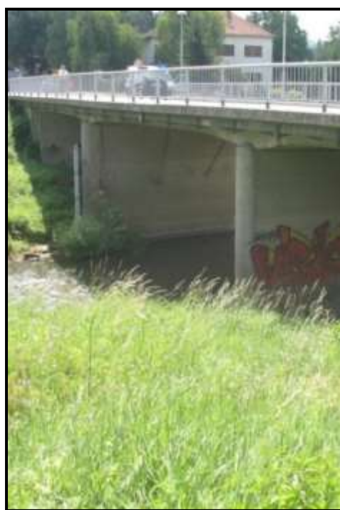
Slika 4-12 Lokacija hidrološke stanice Ludbreg na Bednji – pogled na vodokaz
