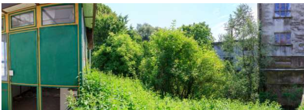
Slika 4-78 Točka 11 – postojeći derivacijski kanal neposredno nakon strojarnice nekadašnje tvorničke hidroelektrane (lokacija izgradnje nove strojarnice)
