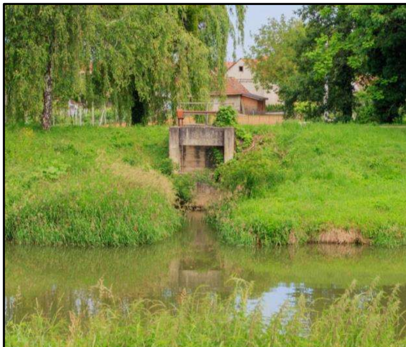
Slika 2-5 Ulazna građevina derivacijskog kanala – vodozahvat
