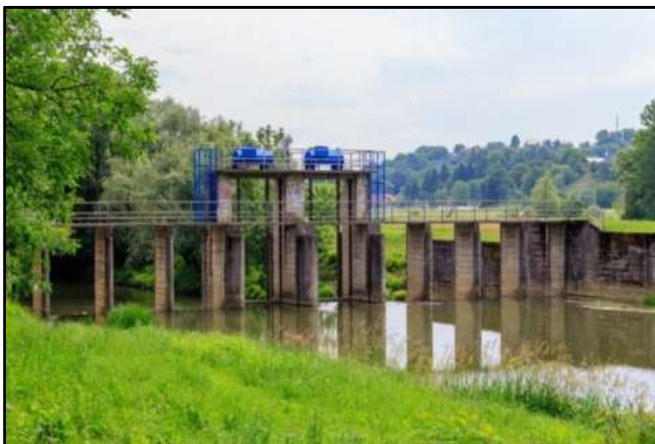
Slika 2-3 Brana na rijeci Bednji
