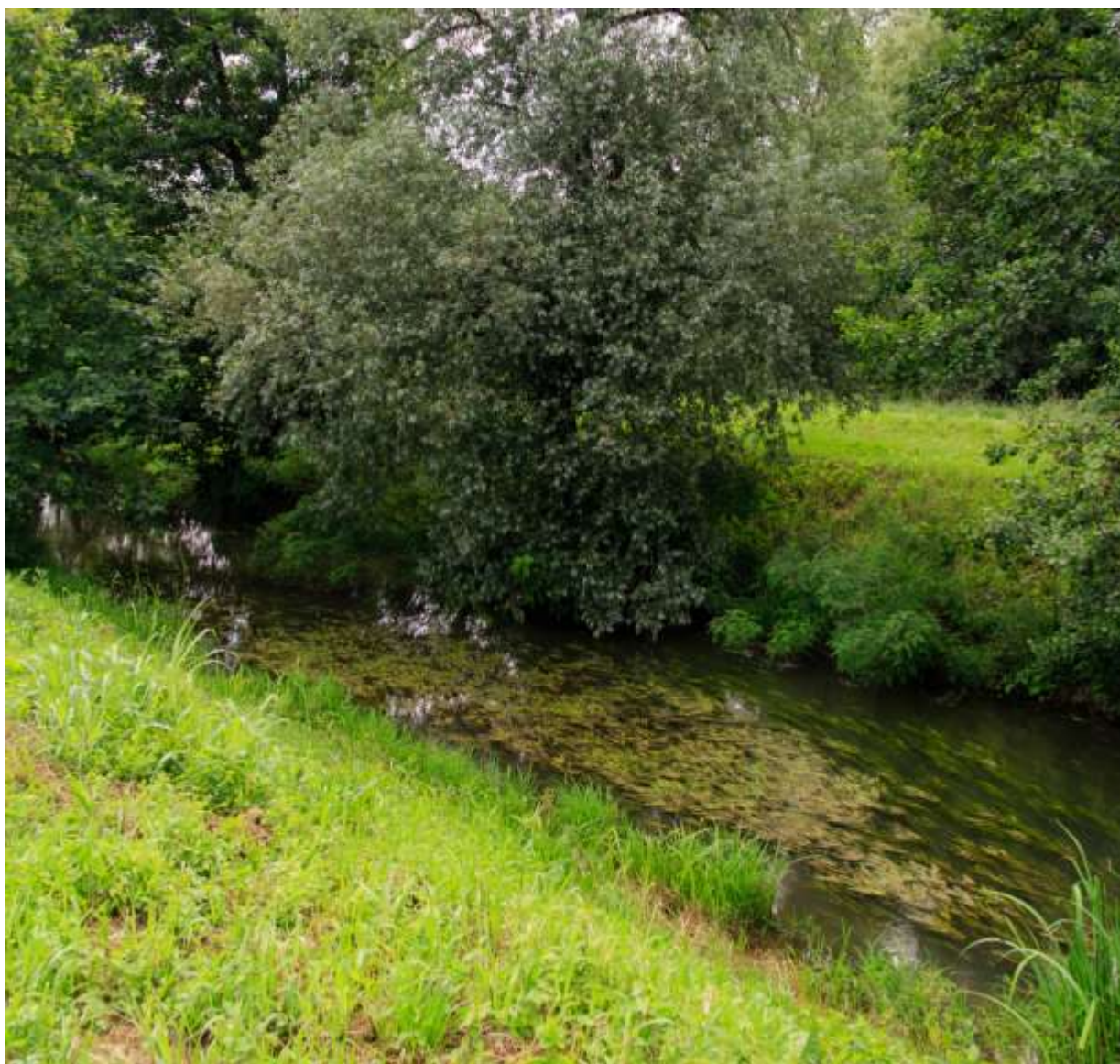
Slika 5-1 Postojeći derivacijski kanal - vidljiv obraštaj pokosa prizemnom i srednjom vegetacijom te grupa stabala razvijena u koridoru kanala
