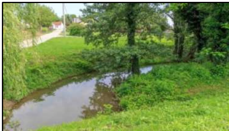
Slika 2-8 Početak donjeg derivacijskog kanala - izlaz iz strojarnice, lijevi kanal je mlinski preljev za velike vode, a desni kanal je izlaz iz difuzora turbine
