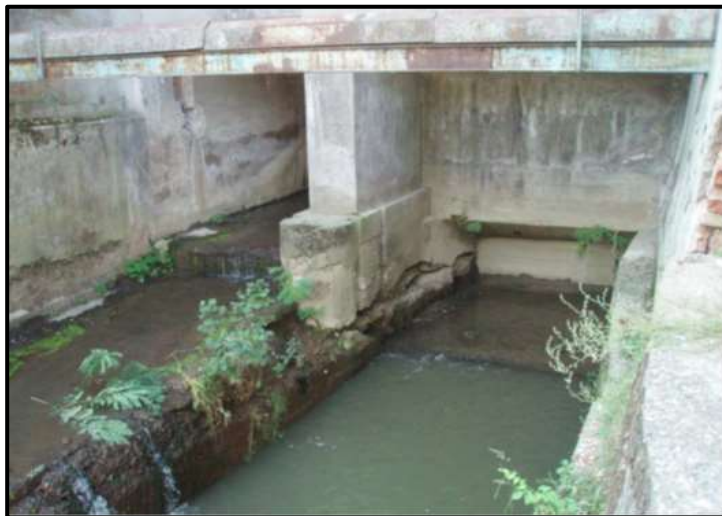
Slika 2-6 Početak gornjeg derivacijskog kanala neposredno nakon vodozahvata
