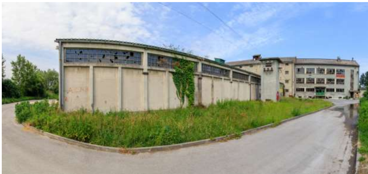
Slika 4-79 Točka 12 – panorama objekata nekadašnjeg skladišta i zgrade mlina (s južne strane)
