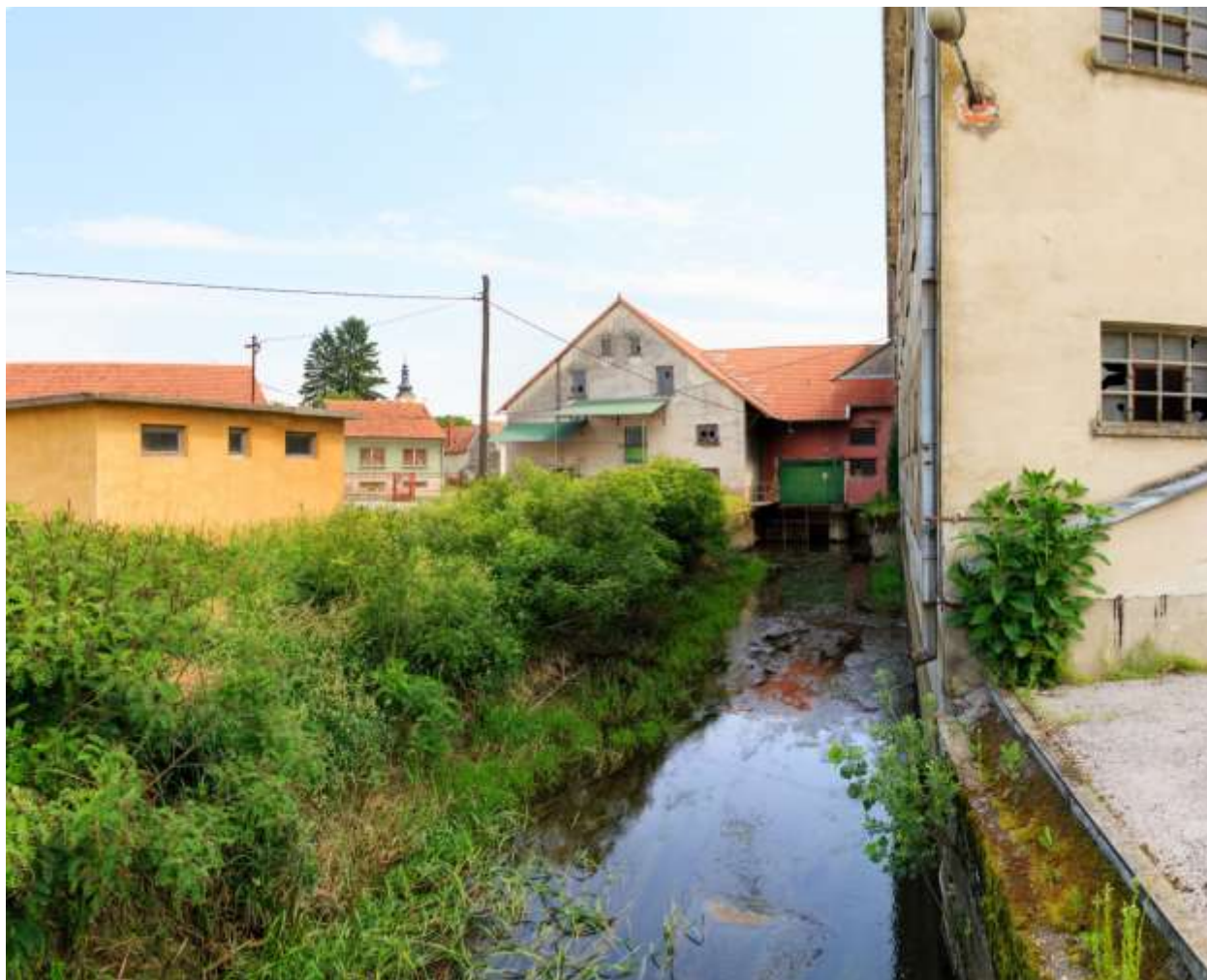
Slika 4-77 Točka 10 – postojeći derivacijski kanal i zgrada nekadašnje strojarnice tvorničke hidroelektrane
