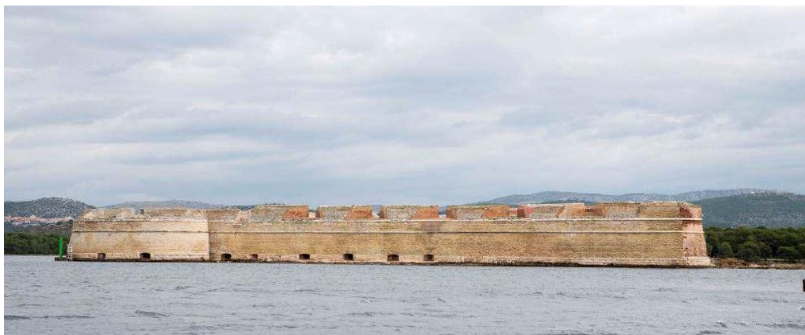
Slika 3.28 Pogled na zapadno pročelje tvrđave sv. Nikole (Izvor: Konzervatorsko tehnički elaborat obnove unutrašnjosti tvrđave)
