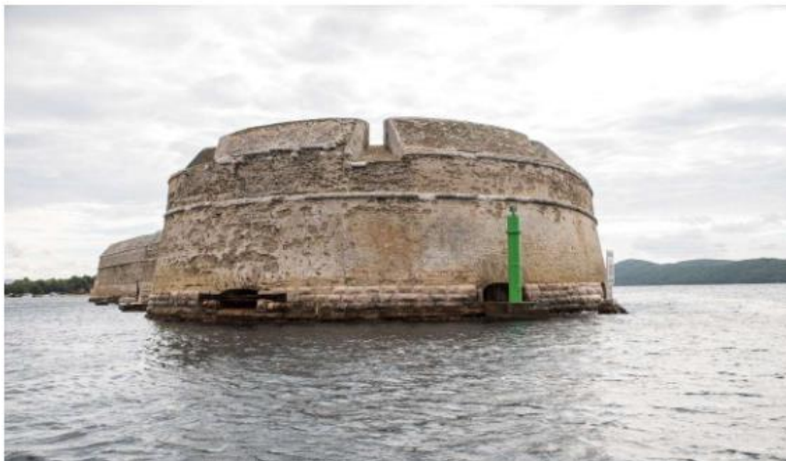
Slika 2.2 Tvrđava sv. Nikole, pogled na sjeverni dio pročelja (rondel) (Izvor: Konzervatorsko-tehnički elaborat obnove plašta tvrđave)
