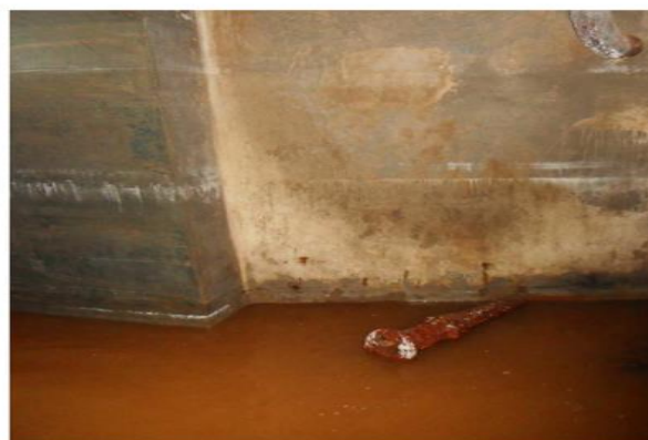
temeljni ispušt komore 3 vodospreme Tegetthoff
