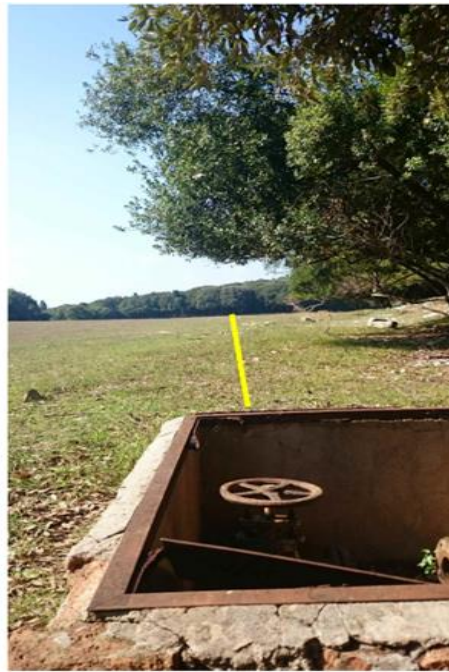
Kanal A - dionica od čv.A2 prema čv.A3 (kod stare pumpne stanice)
