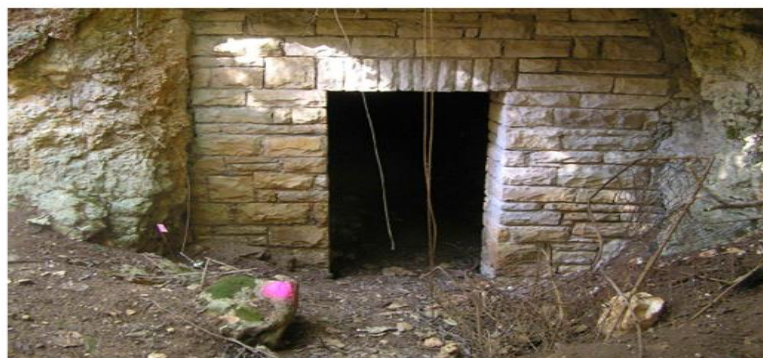
Kanal T (VS Teget) - ulaz u tunel na dionici između čvorova T5 i F2
