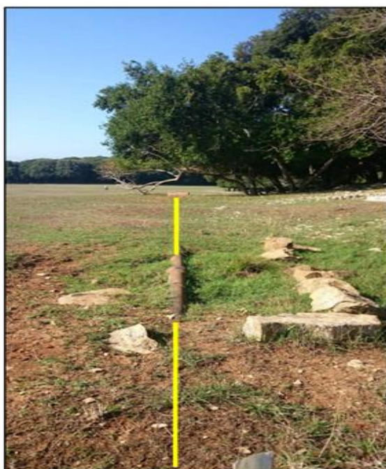
Kanal B - dionica od čv. B7 prema čv. B8 (cijev na površini)
