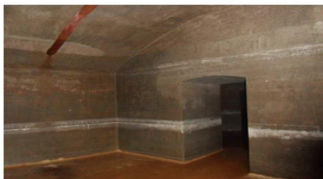
komora 3 vodospreme Tegetthoff
