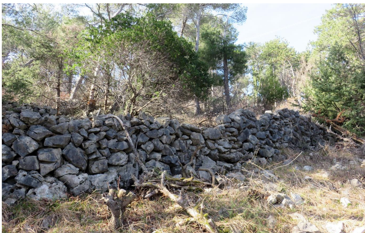
Slika 39 Suhozidi na trasi novo planirane prometnice
