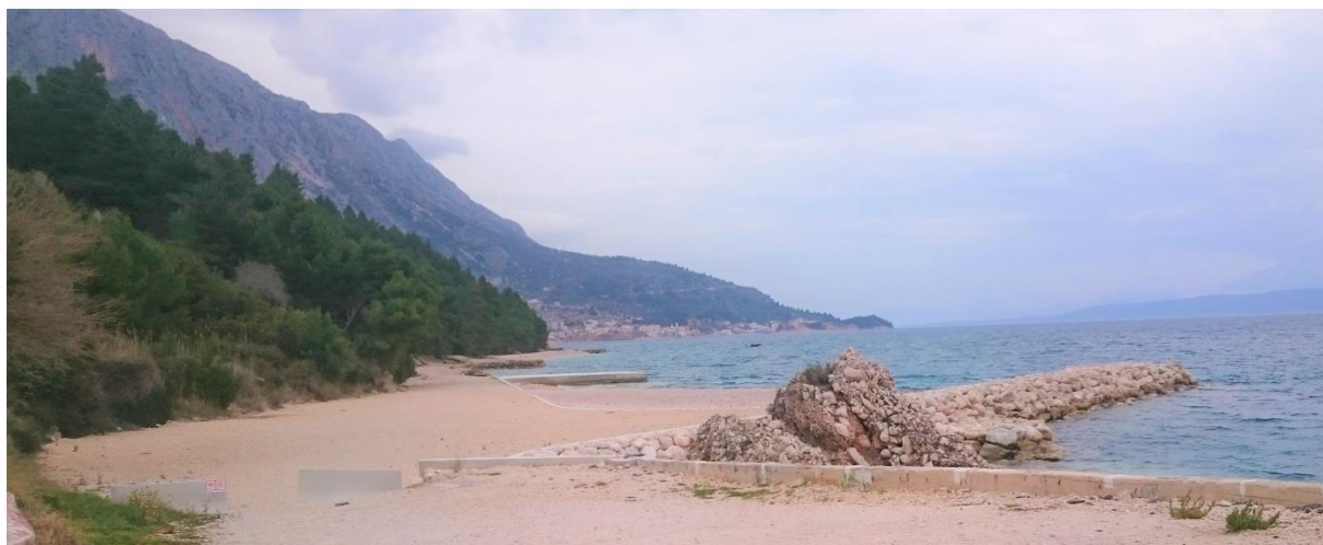
Slika 1.1-5 Izvedeno stanje, pogled sa zapada (Zeleni servis d.o.o., 05.03.2019.)
