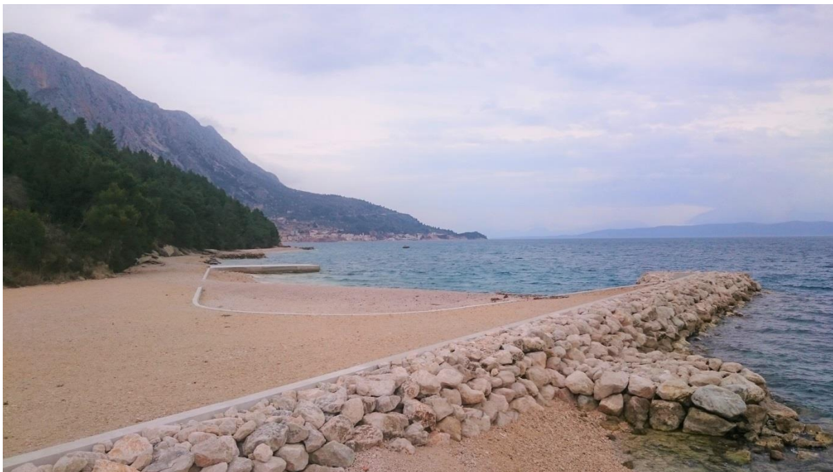
Slika 1.1-6 Izgled izvedenog valobrana (Zeleni servis d.o.o., 05.03.2019.)
