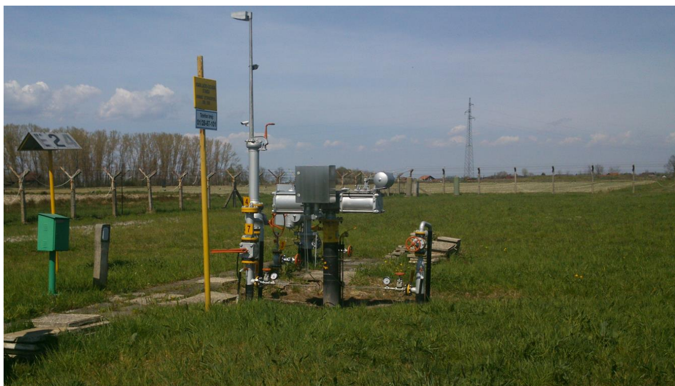
Sl.2.1-7: Upravljačka jedinica na blokadnom uređaju uz plinsku čvornu stanicu na DN 500
