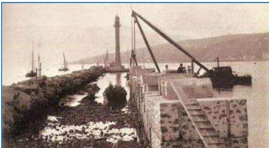
Slika 12. Detalj gradnje Riječkog lukobrana
