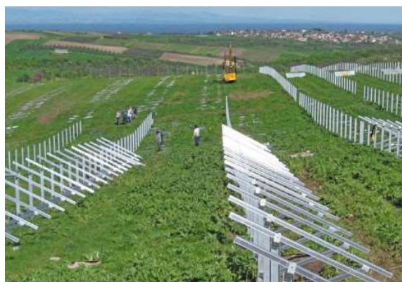
Slika 2: Detalj montaže na zemljanoj površini
