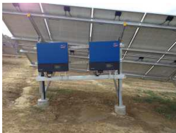
Slika 3: Način montaže invertera na podkonstrukciju
