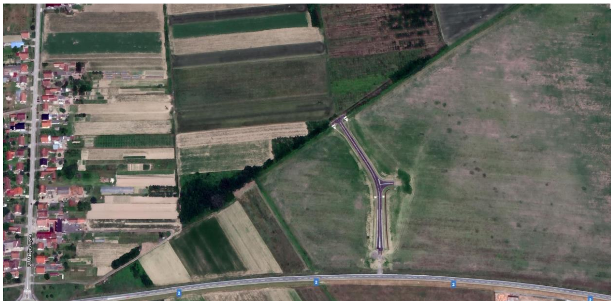
Slika 1. Izvedeni dio prometnice u Poduzetničkoj zoni Turbina 3 (izvor: Google Earth pro).
