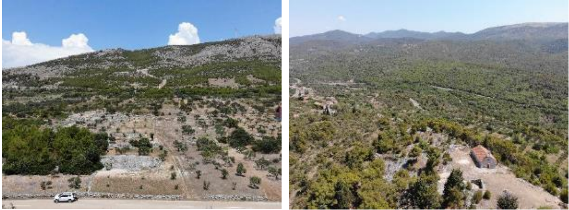
Slika 3.3-1: Pogled na područje planirane trase dalekovoda (prolaz preko Grebaštice – lijevo i prolaz između naselja Plencići i crkve Sv. Ivana – desno)
