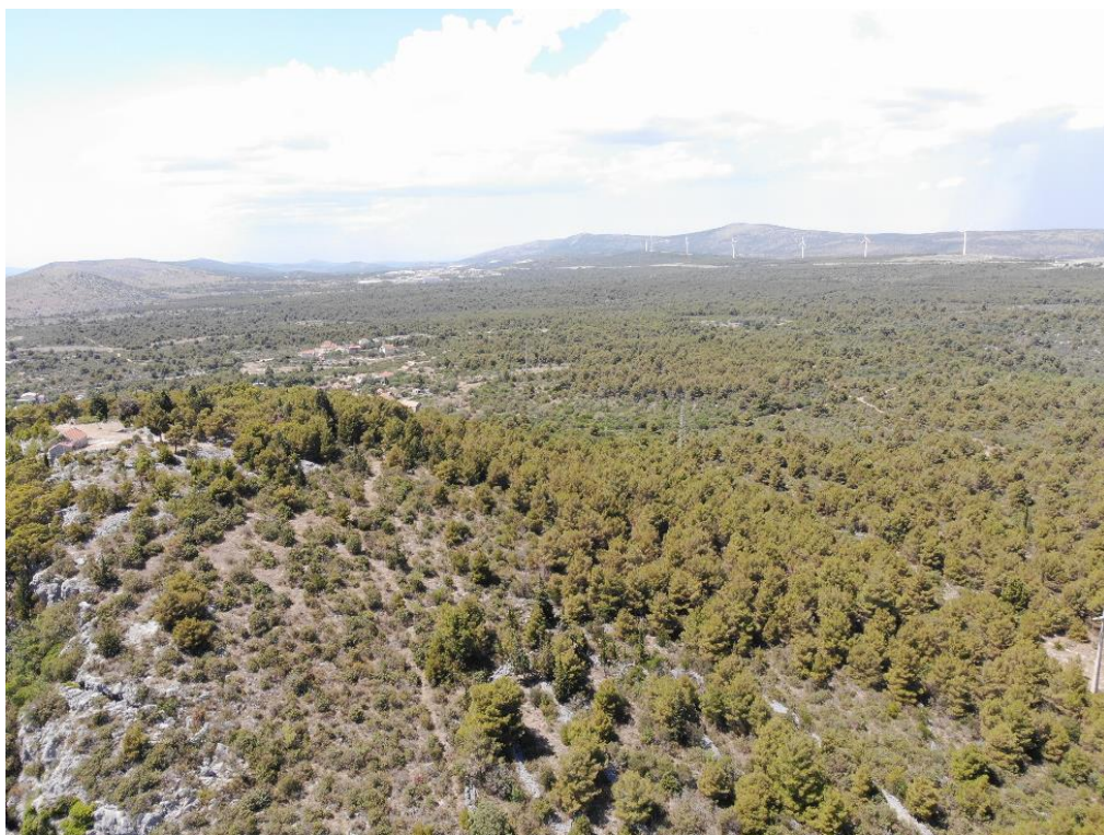
Slika 3.5-4: Područje trase planiranog dalekovoda od Grebašnice do Industrijske zone Podi
