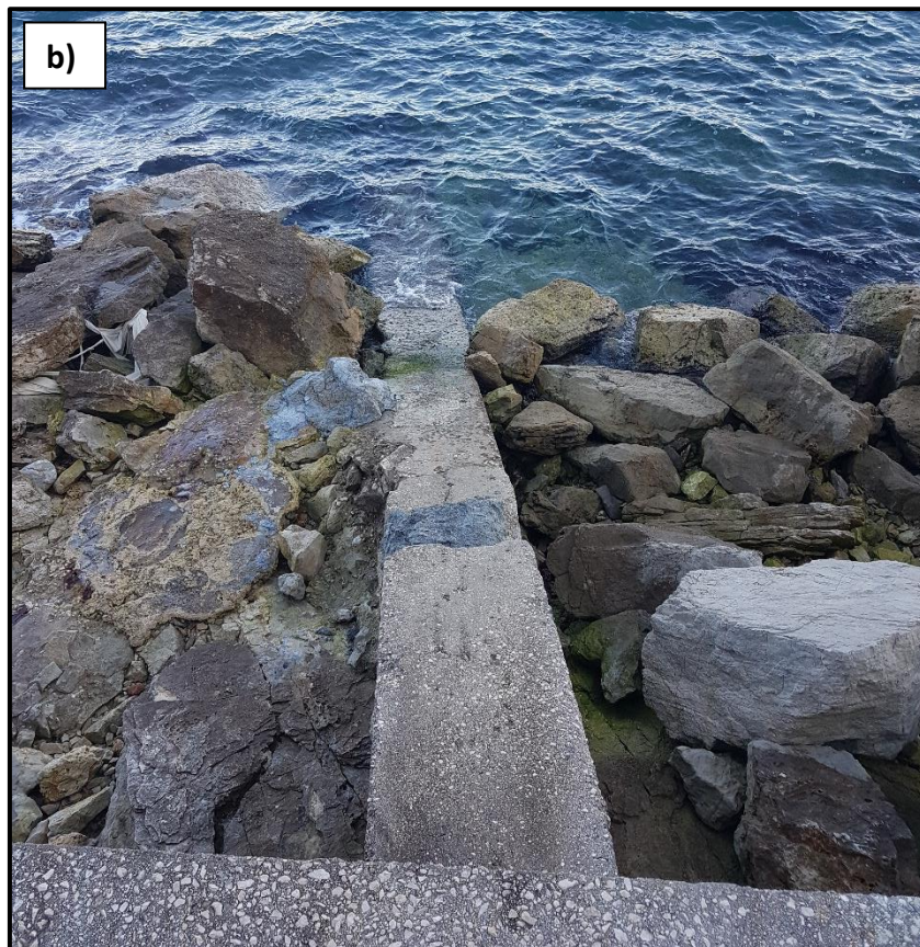
Slika 2.1-1. Postojeći UPOV (a) i obalni ispust (b) – snimljeno u prosincu 2019. godine
