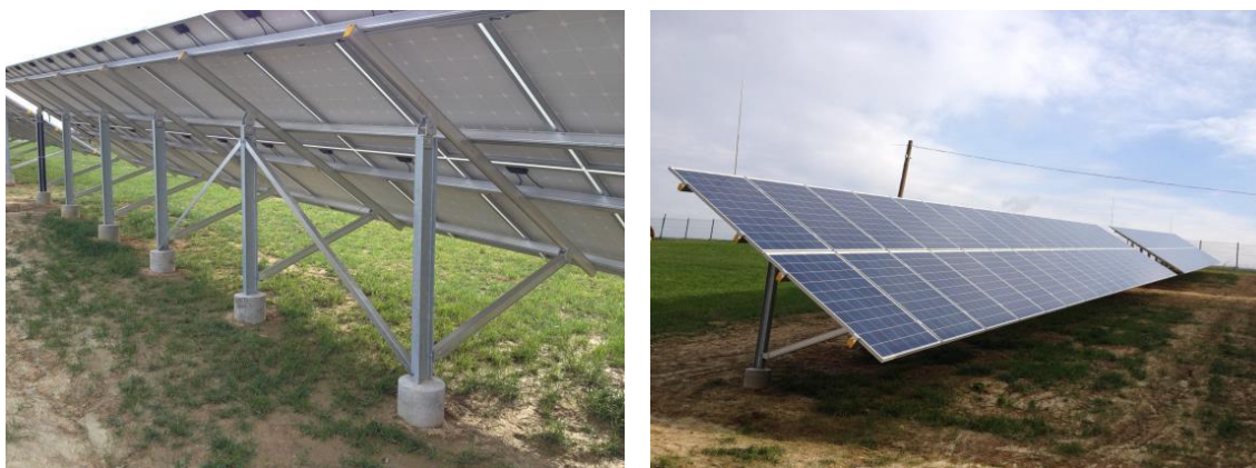
Slika 4: Detalj montaže na zemljanoj površini
