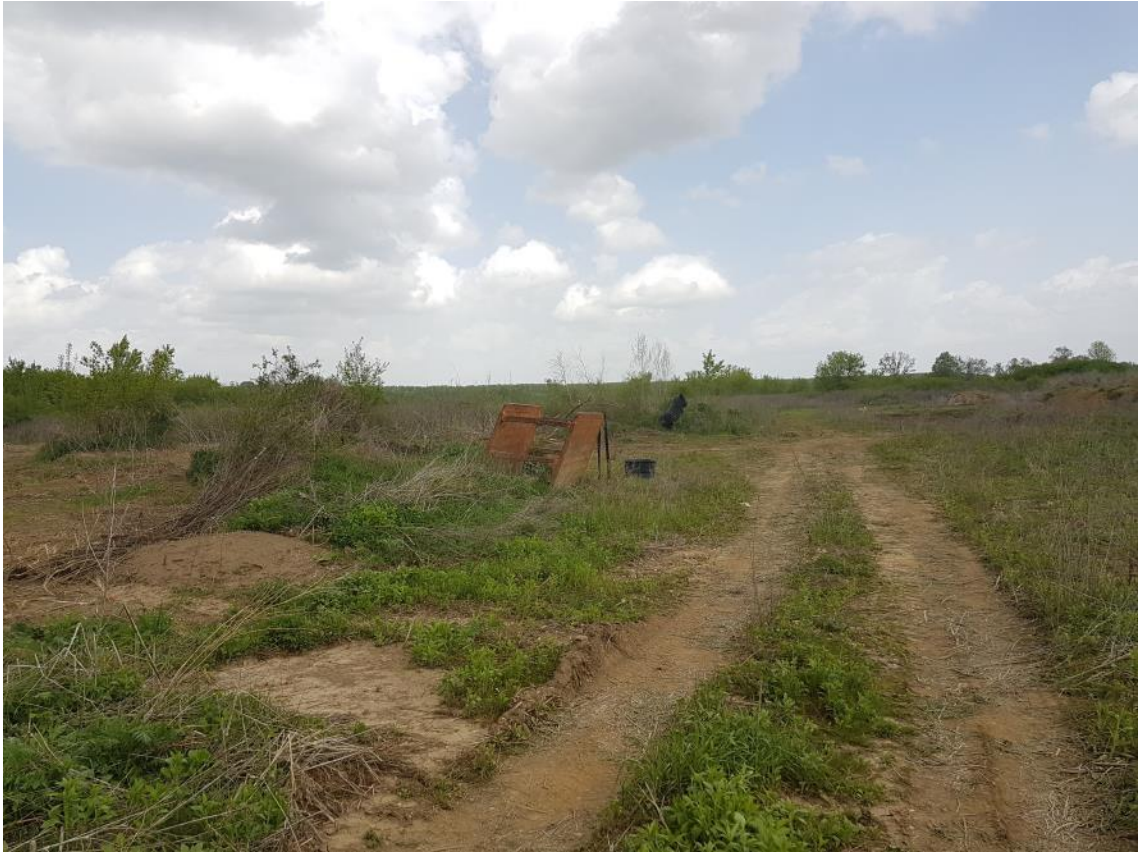
Slika 2-22 Lokacija planiranog zahvata (travanj 2019. – centralni dio lokacije)
