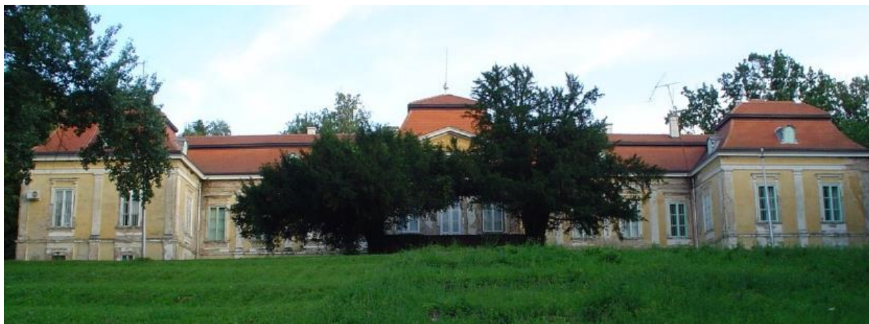
Slika 2.1 Sjeverno pročelje – pogled sa sjevera (Izvor: Konzervatorska studija, broj 05-66)
