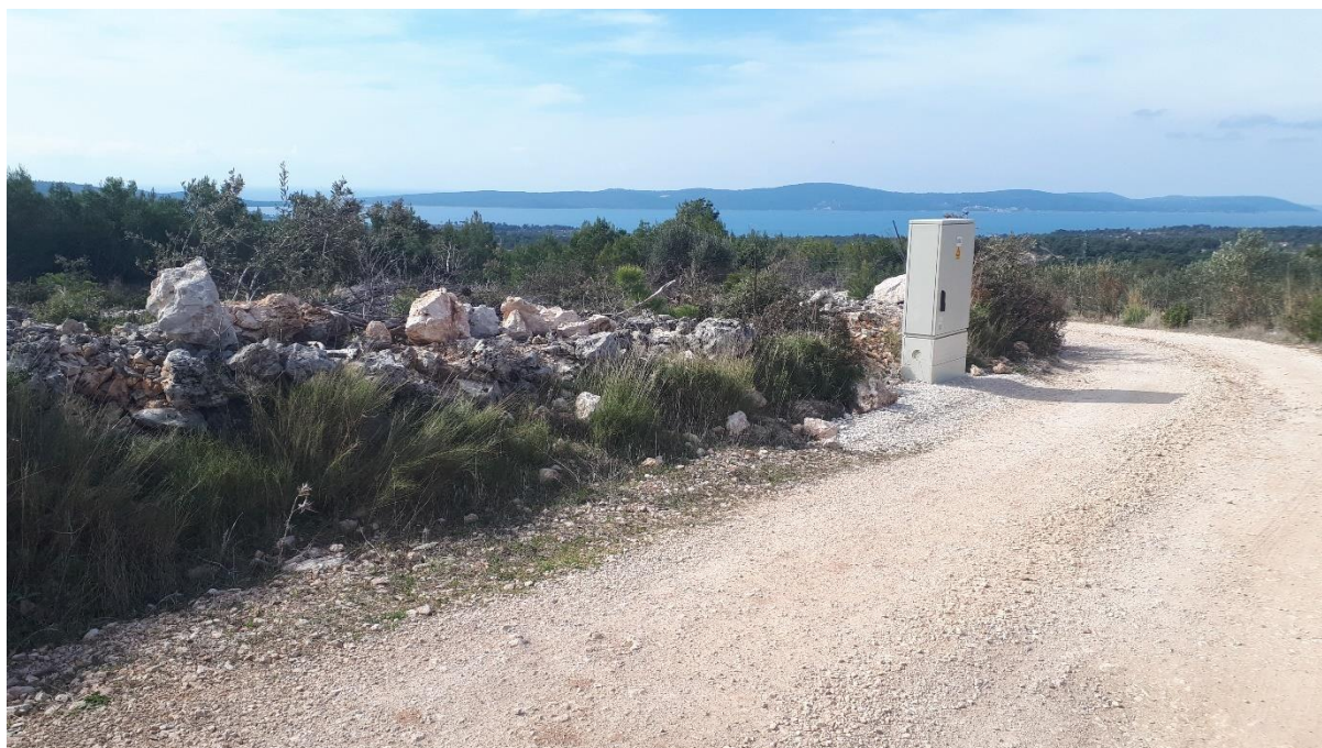
Slika 8. Pogled od lokacije vodospreme prema predjelu Paklenica
