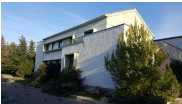
Objekt 1 – Upravna zgrada
