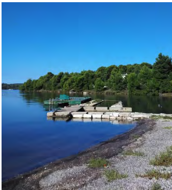
Slika 5. Betonska struktura na lokaciji gata A
