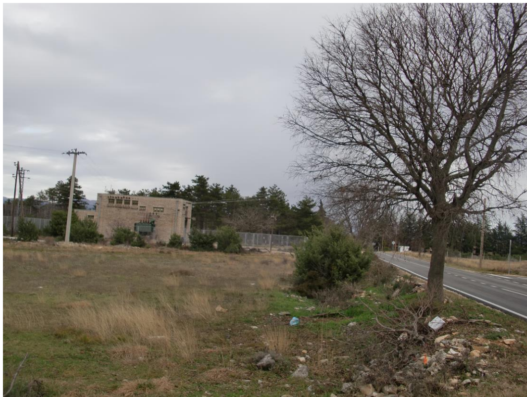
Slika 34. Trafostanica uz državnu cestu DC59
