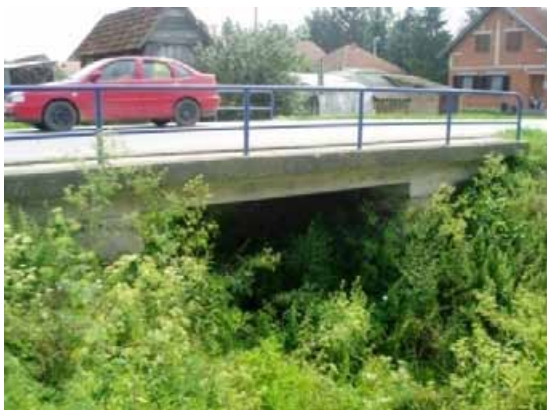
Slika 5. Pločasti propust preko kanala Bojana u km 0+709,00
