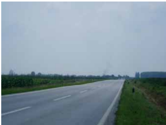
Slika 21. Dionica između Čemince i Švajcarnice
