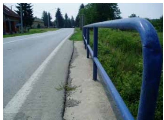
Slika 6. Ograda na pločasti propust preko kanala Bojana
