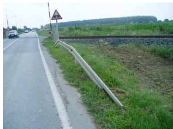
Slika 22. Prijelaz preko željezničke pruge Osijek – Beli Manastir
