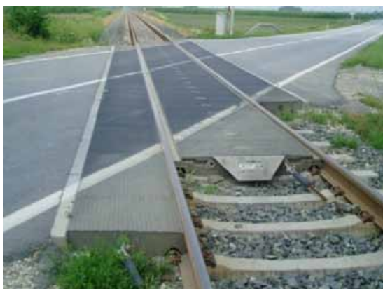
Slika 23. Prijelaz preko željezničke pruge Osijek – Beli Manastir
