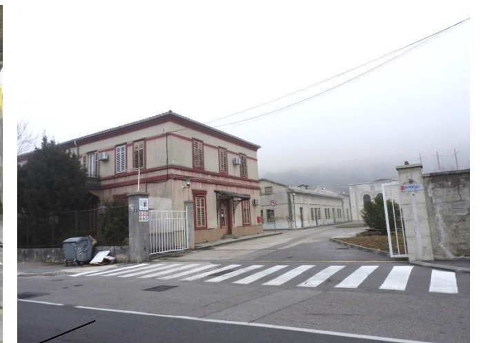
Ulaz na lokaciju i upravna zgrada
