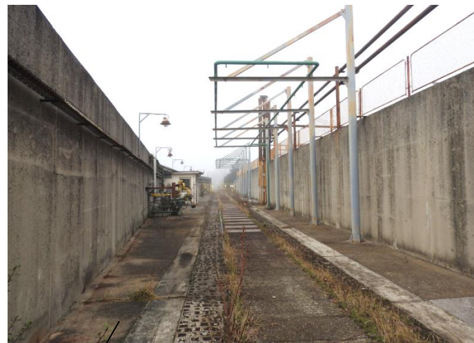
Pretakalište vagon cisterni
