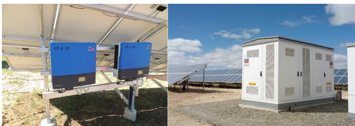
Slika 2.1-3 Koncepti smještaja izmjenjivača – izmjenjivači male snage (lijevo), izmjenjivači veće snage (desno)
