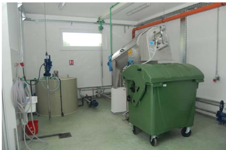
Slika 1.2 Dehidracija mulja na filter-presi
