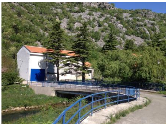
Pogled na strojarnicu CS Žrnovnica (snimak sa pristupne ceste)
