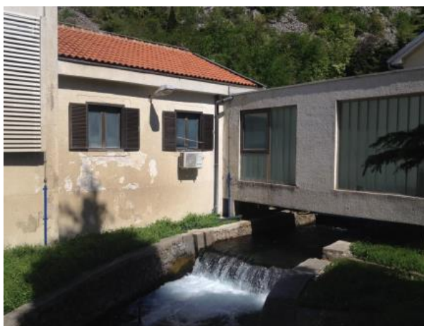
Pogled na strojarnicu i toplu vezu prema starom dijelu zgrade (u podnožju prolazi vodotok u uređenom koritu potoka Žrnovnica)
