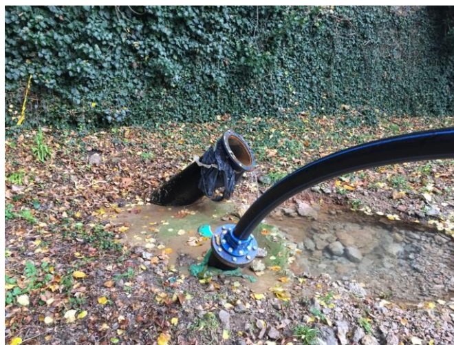
Slika 2.2-1. Vrhovi cijevi izvedenih istražnih bušotina PŽ-16 i PŽ-17
