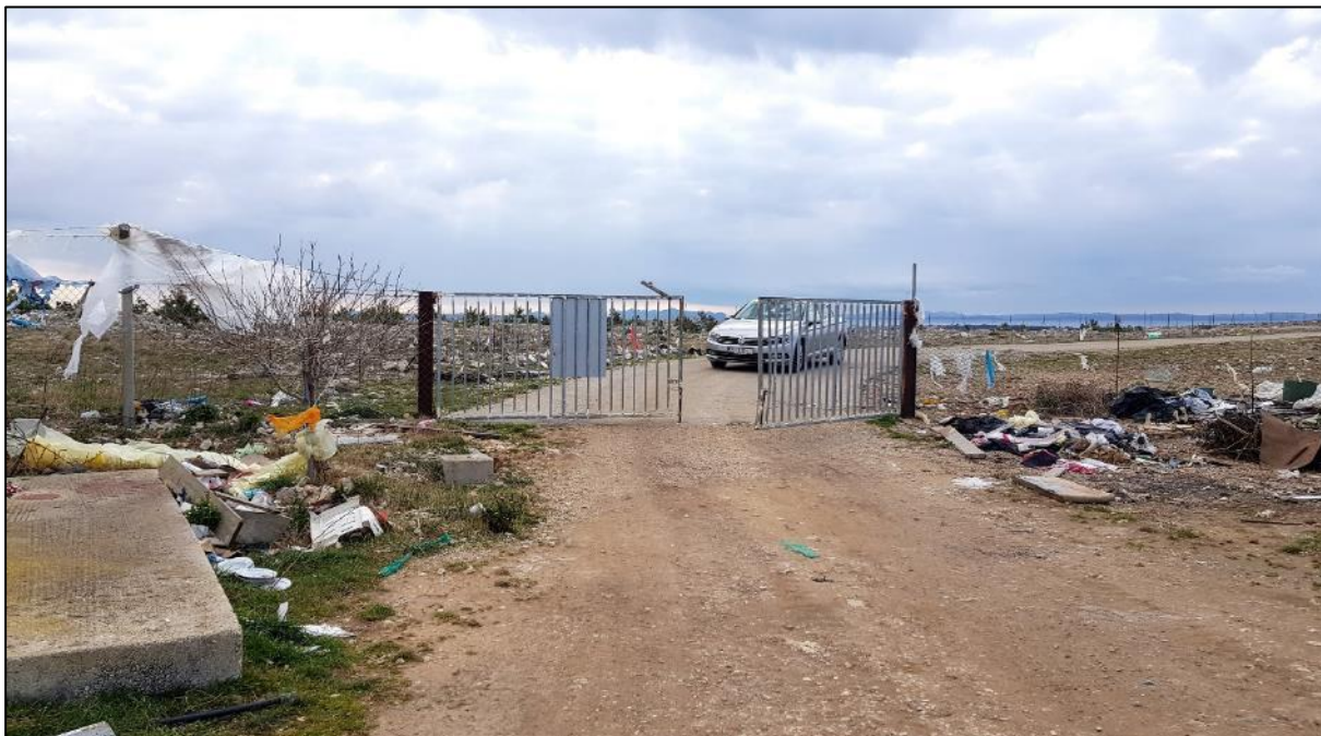
Slika 2.1.-2. Postojeće stanje lokacije, ulaz na prostor odlagališta
