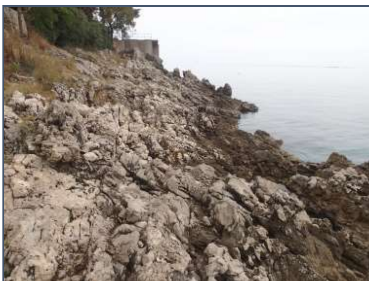
Slika 2a. Posljedice korozije i bioerozije vapnenaca
