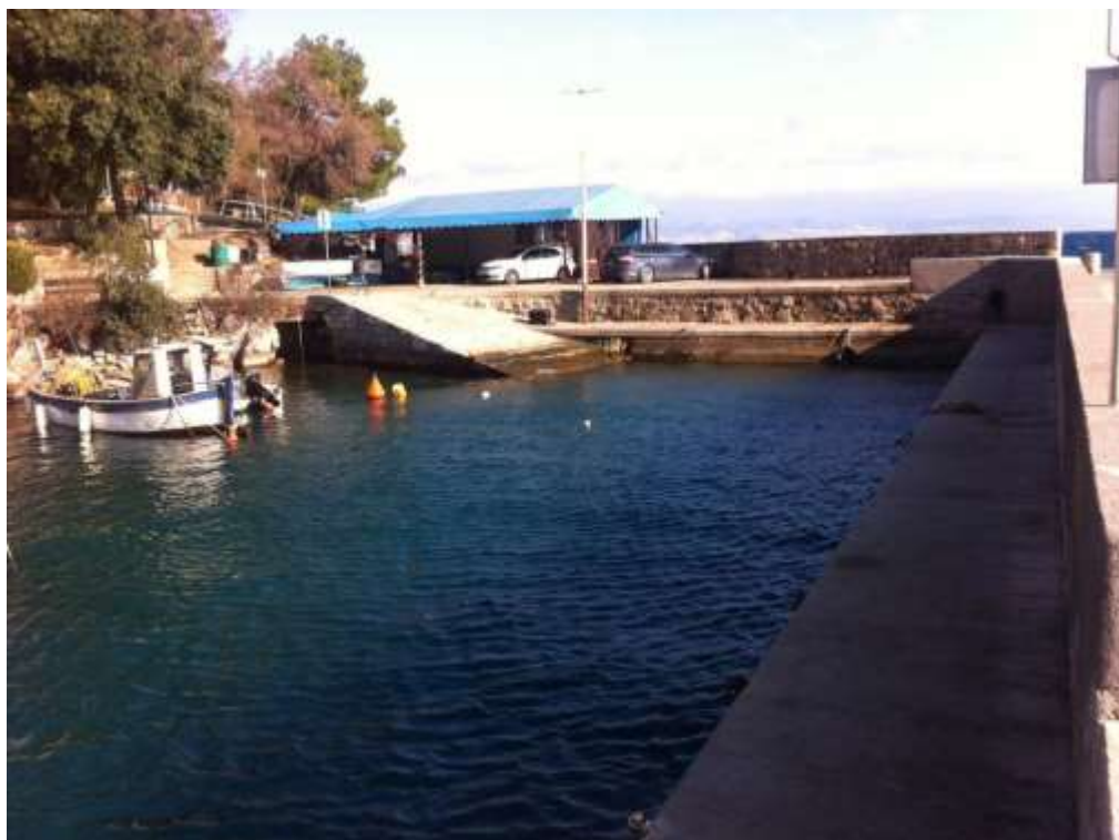
Pogled na korijen postojećeg lukobrana
