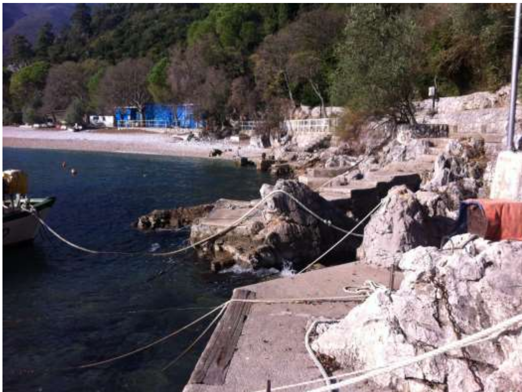
Neuređena privezišta komunalnih vozova
