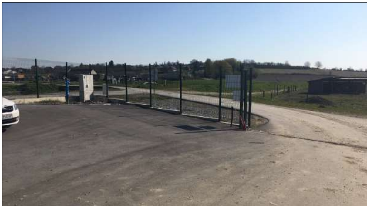
Slika 2.2.-2 Prikaz ulaznog prostora odlagališta
