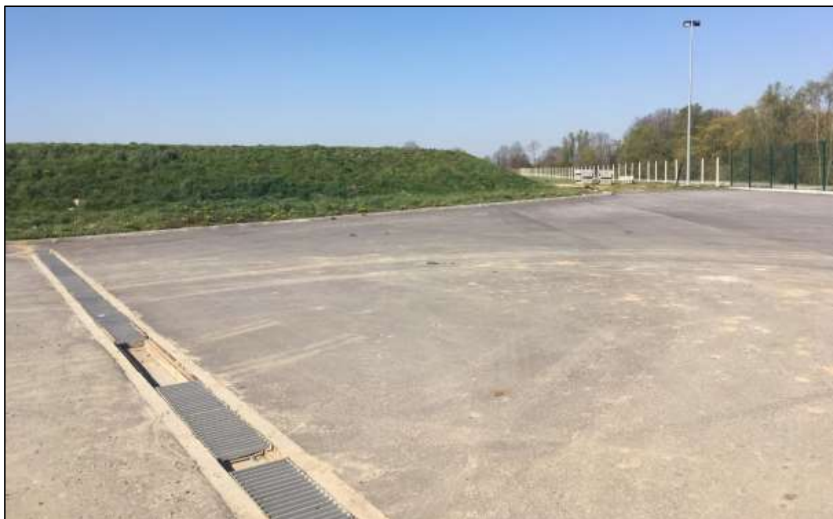
Slika 2.2.-4 izvedeni sustav odvodnje otpadnih voda ulazno-izlazne asfaltirane površine
