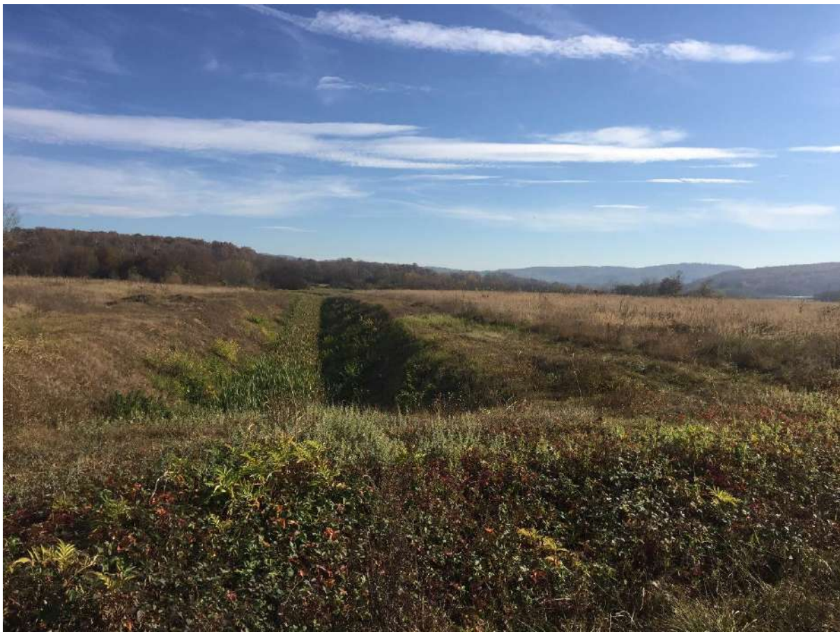
Slika 6.1: Pogled na trasu spoja Šumetlice i Rešetarice s djelomično izvedenim spojnim kanalom (pogled sa županijske ceste Ž 4140, oko 600 m sjeverno od raskrižja sa županijskom cestom Ž 4141)
