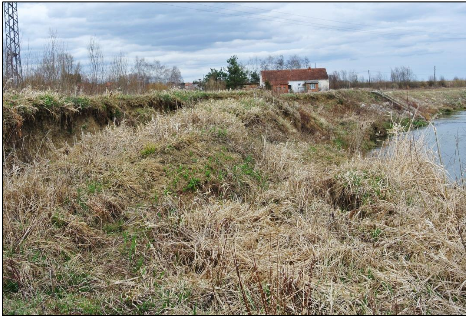
Slika 5. Postojeće stanje planirane lokacije ispusta u rijeku Bednju koja će se obložiti kamenom oblogom zbog erozijskog djelovanja vode
