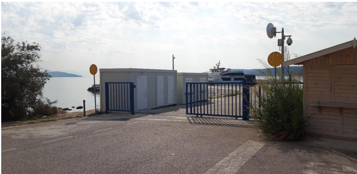
Slika 1.1-2 Postojeći objekti uz čeličnu kliznu ogradu (izvor: Zeleni servis d.o.o. od 21.09.2020.)
