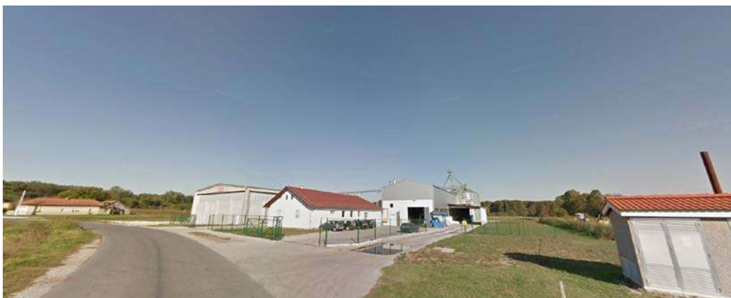
Slika 1.1.1.1. Lokacija zahvata pogled s istočne strane na lokaciju postojećeg pogona
