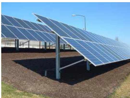
Slika 2: Detalj montaže na zemljanoj površini
