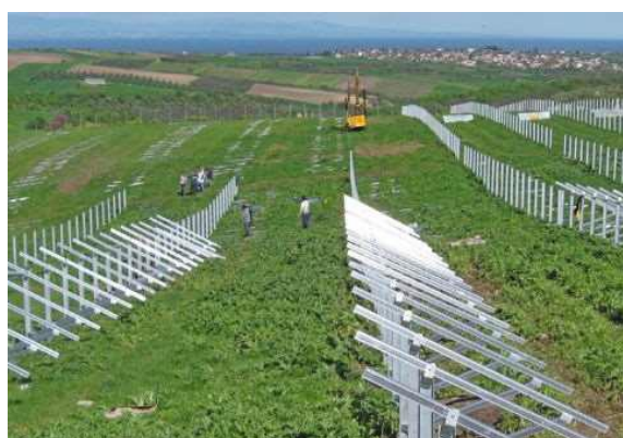
Slika 2: Detalj montaže na zemljanoj površini
