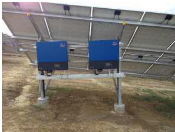
Slika 3: Način montaže invertera na podkonstrukciju
