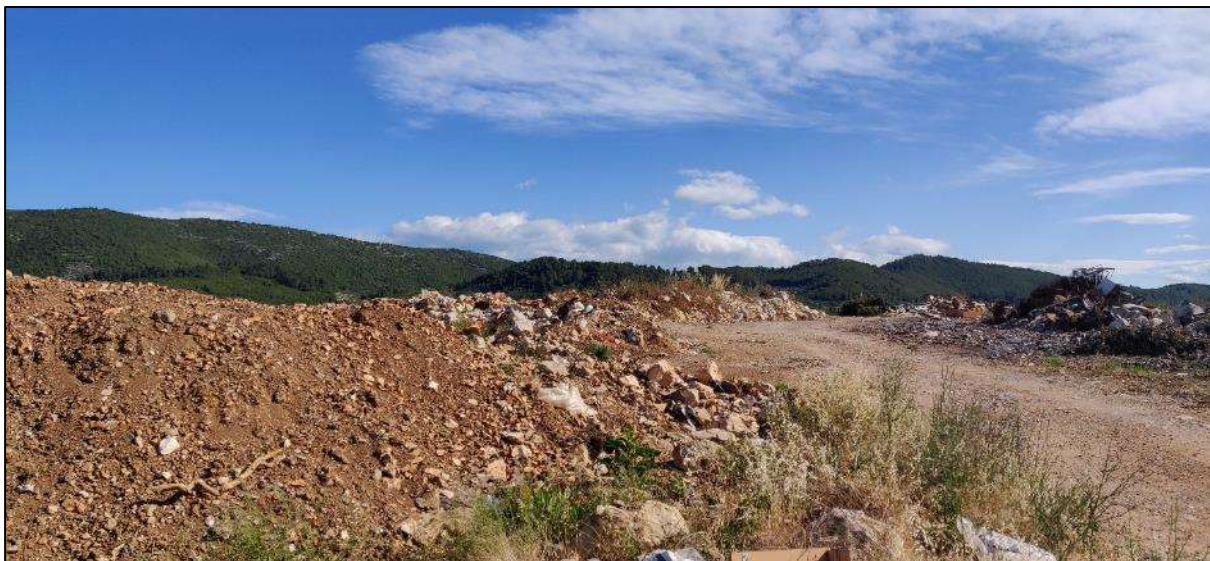
Slika 2.2.-5 pogled na centralni plato odlagališta
