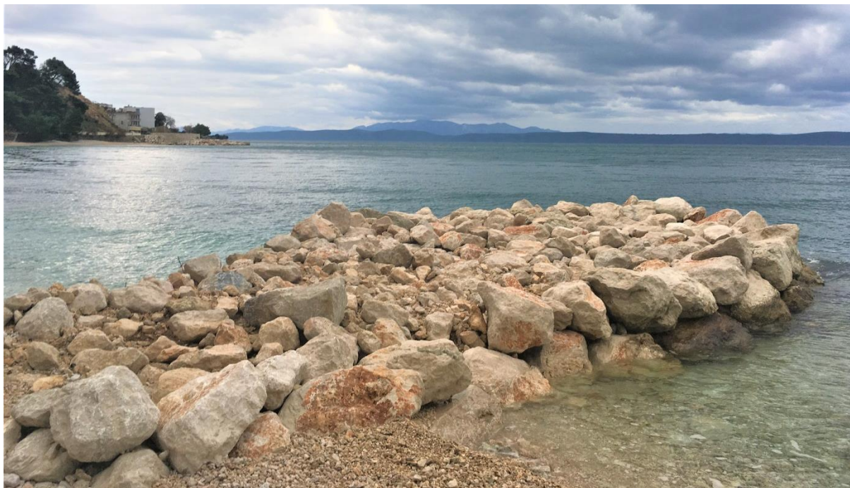
Slika 1.1-3 Izgrađeni valobran (Zeleni servis d.o.o. prosinac 2019.)
