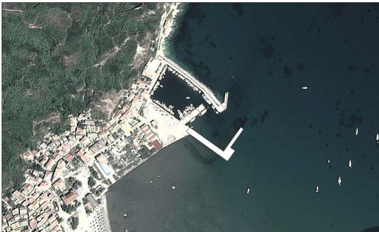
Slika 2: Prikaz postojećeg stanja luke Susak (Izvor: Maritimna studija dogradnja pristana i rampe za ro-ro putničke brodove u luci Susak faza 3.i 4., Pomorski fakultet, Sveučilište u Rijeci, Rijeka, prosinac 2018.)
