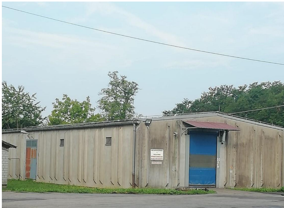
Slika 13. Skladište gotovih proizvoda na kojem se planira postavljanje FN modula
